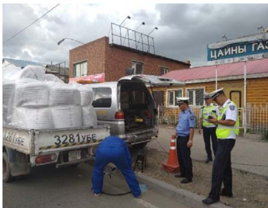
Зураг 16. ЗГА-ай хамтран тээврийн хэрэгсэлийн яндангаас гарах хорт хийн утааг хэмжих хяналт шалгалт хийж байгаа нь.
