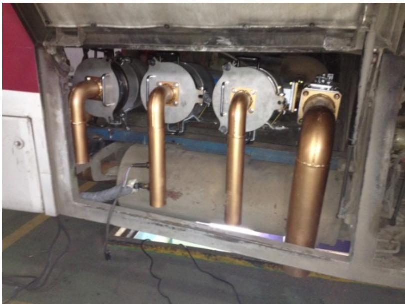
DPFの設置状況
