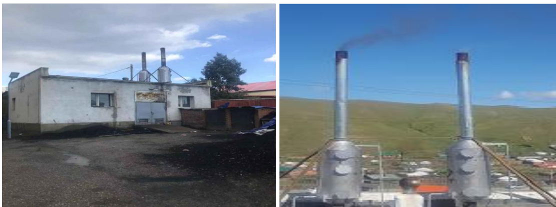
Зураг 3. Халаалтын зууханд утаа шүүгч суурилуулсан байдал
