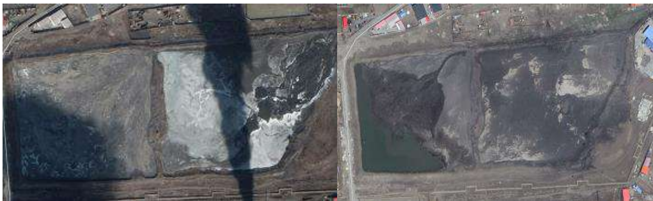
Зураг 8-2 ДЦС-2-ын үнсэн сангийн ашиглалтын байдал (2018 оны хавар, өвөл)
