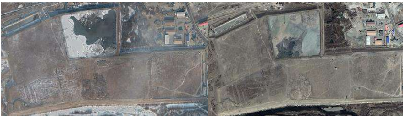
Зураг 8-3 ДЦС-3-ын үнсэн сангийн ашиглалтын байдал (2018 оны хавар, өвөл)
