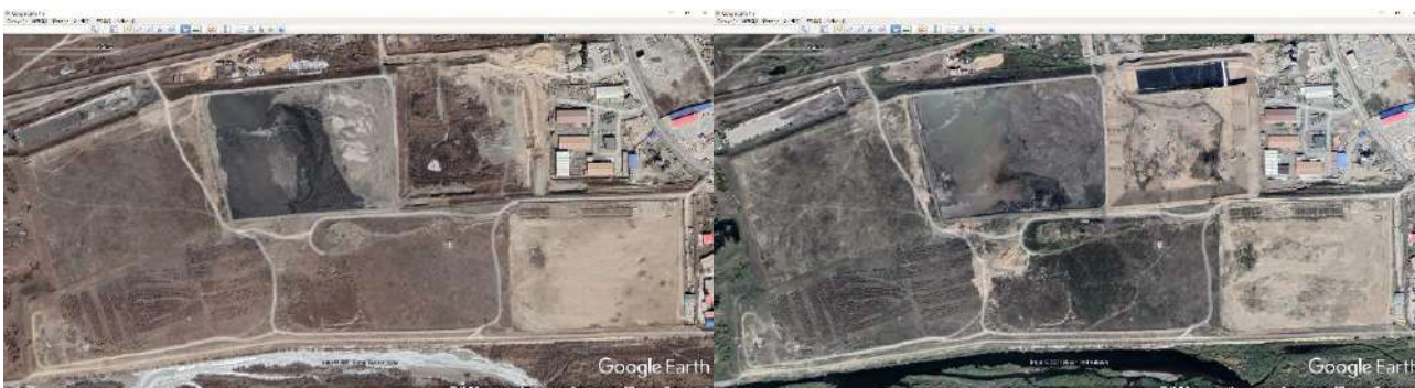
Зураг 8-3 ДЦС-3-ын үнсэн сангийн ашиглалтын байдал (2020 оны хавар, өвөл)
