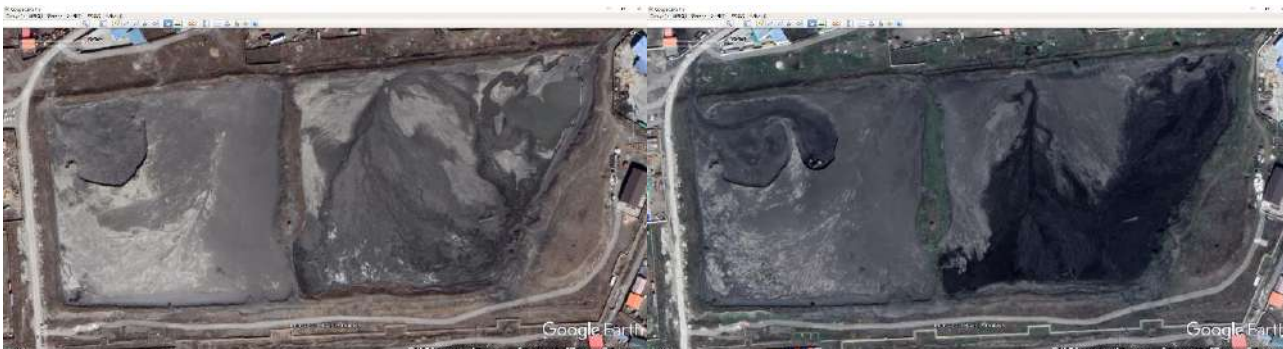
Зураг 8-2 ДЦС-2-ын үнсэн сангийн ашиглалтын байдал (2020 оны хавар, өвөл)
